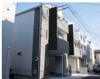
本牧元町【中区本牧元町】2棟
